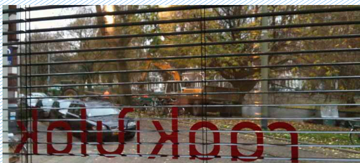
Het baggeren in november vanuit Raakvlak gezien.
