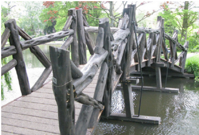
figuur 4. Brug in Gouda
