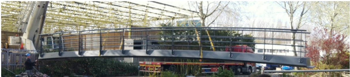
figuur 6. Typische standaardontwerp composietbrug
